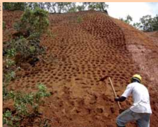
Ações de contenção têm o apoio da comunidade.
